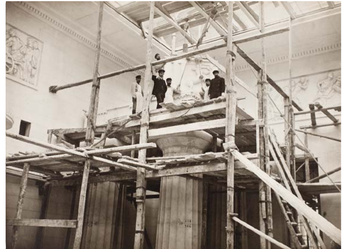
1. Установка слепка метопы Парфенона. Музей изящных искусств имени императора Александра III при Московском университете (ныне ГМИИ им. А.С. Пушкина) Construction of the metopes of the Parthenon copy. Museum of Fine Arts of the Emperor Alexander III at the Moscow University (today — the Pushkin State Museum of Fine Arts). © ГМИИ им. А.С. Пушкина, 2019.
